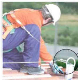
Fig. 4: Operatore ancorato alla linea vita e al dispositivo antipendolo.
